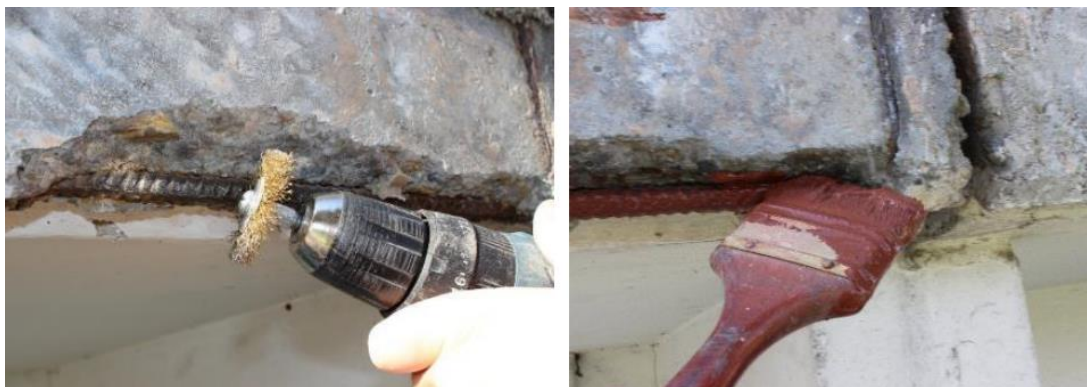
Rys.2. Czyszczenie i zabezpieczenie antykorozyjne stali zbrojącej
