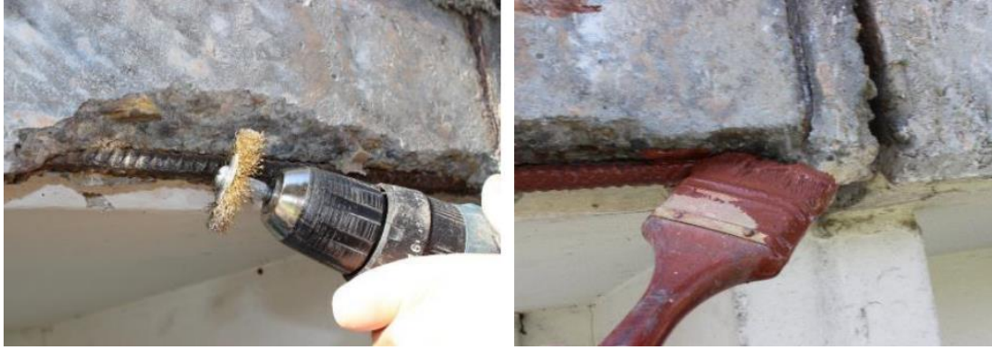
Rys.2. Czyszczenie i zabezpieczenie antykorozyjne stali zbrojącej
