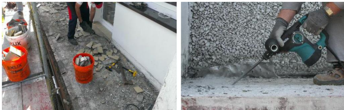
Rys.1. Przygotowanie podłoża – odsłonięcie i oczyszczenie płyty konstrukcyjnej
