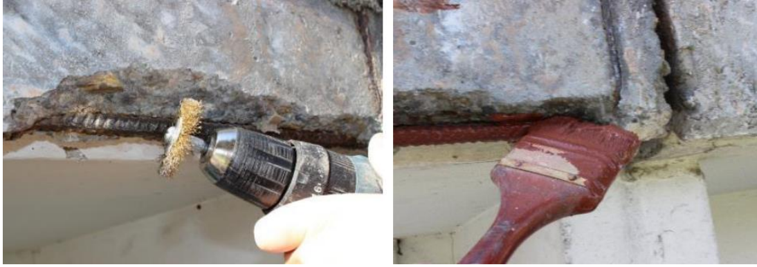
Rys.2. Czyszczenie i zabezpieczenie antykorozyjne stali zbrojącej
