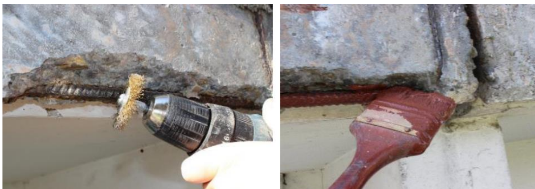
Rys.2. Czyszczenie i zabezpieczenie antykorozyjne stali zbrojącej
