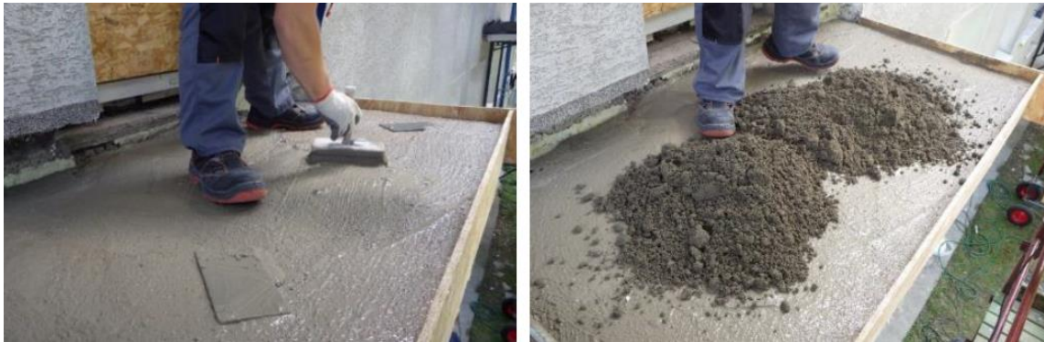
Rys.4. Wykonanie warstwy spadkowej
