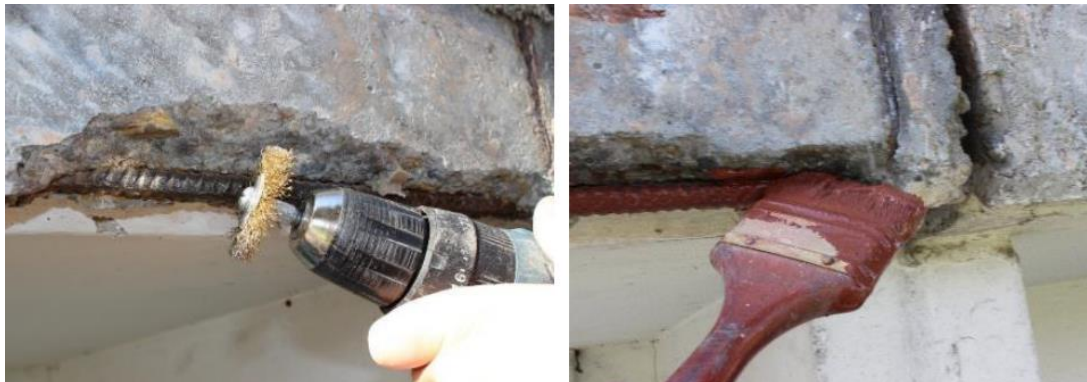
Rys.2. Czyszczenie i zabezpieczenie antykorozyjne stali zbrojącej
